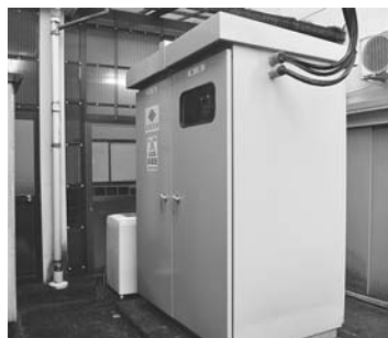
大和荘変電施設
