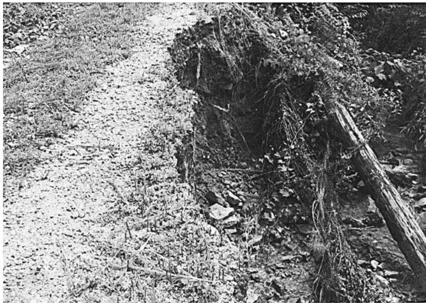
要望が出ている崩落現場
