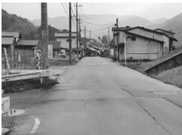
外側線が消えた危険な道路 (浜原連担地内)
